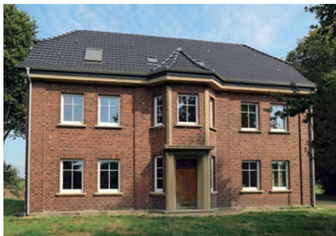
Energetische Sanierung eines Bauernhauses, Umbau zum Mehrfamilienhaus mit 4 Wohnungen, Garagen und Wirtschaftsräumen
