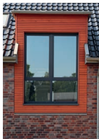
Neubau eines Wohnhauses mit Garage
